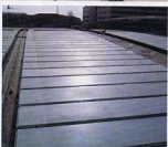
Fase finale posa dei gradini
